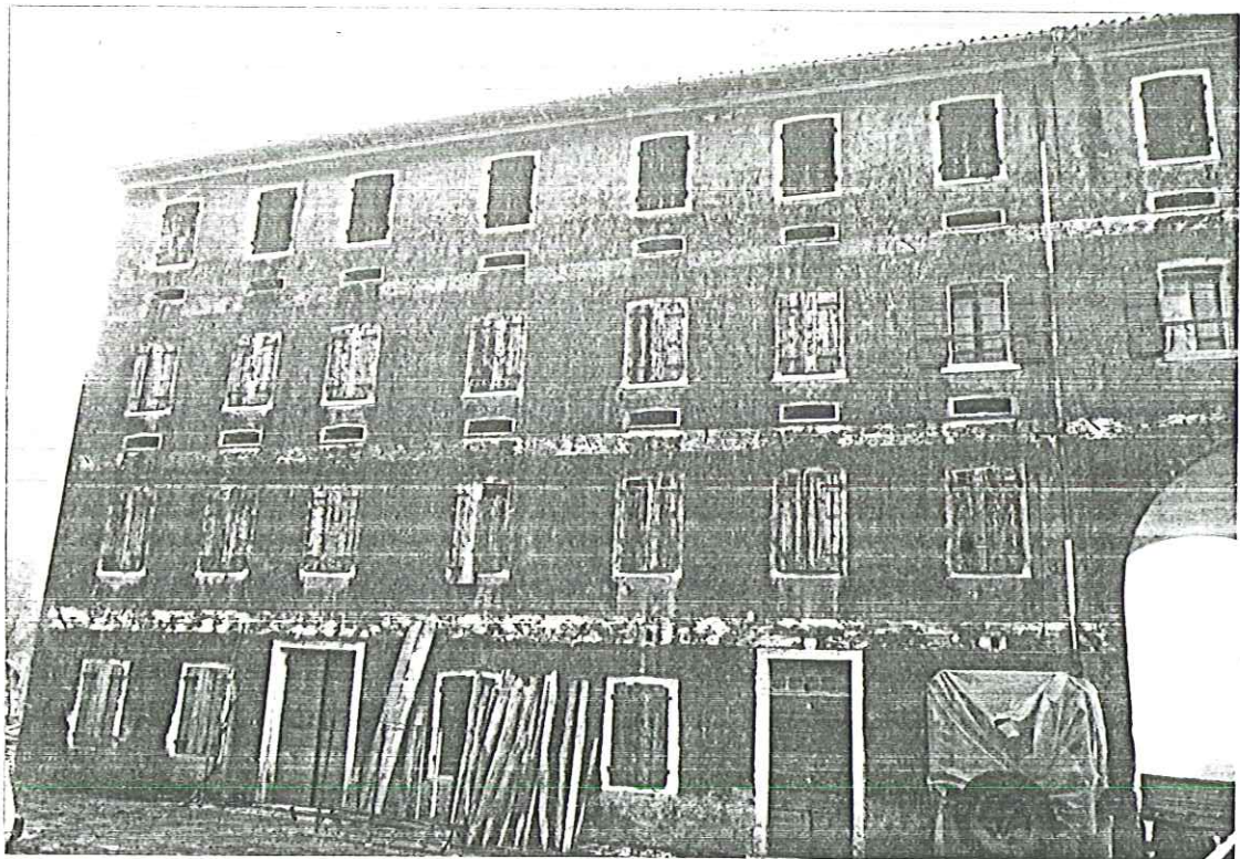
prospetto sud lato sinistro
